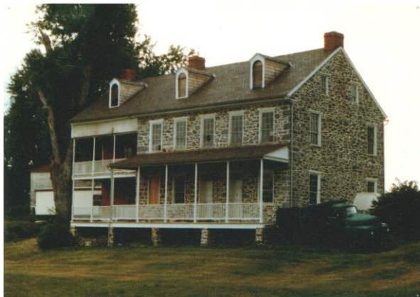
Vor der Renovation
