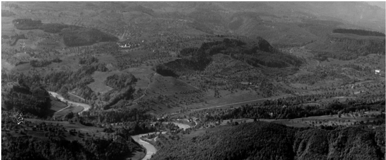
Sihlbrugg-Neuheim 1919 von Walter Mittelholzer Quelle ETH E-Pics
