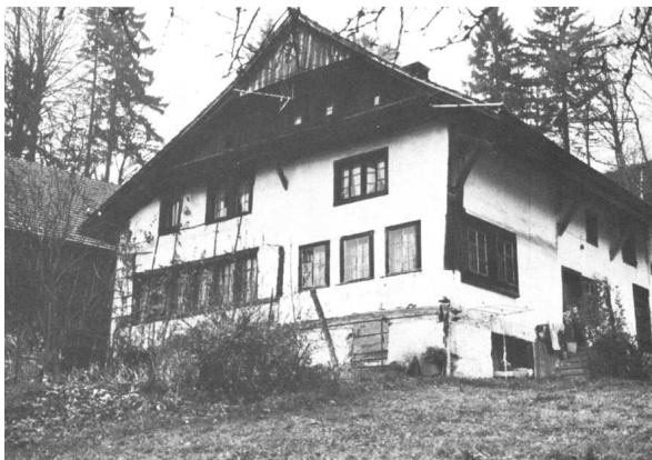
Vor dem Abriss
