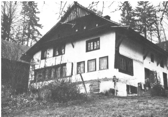
Vor dem Abriss
